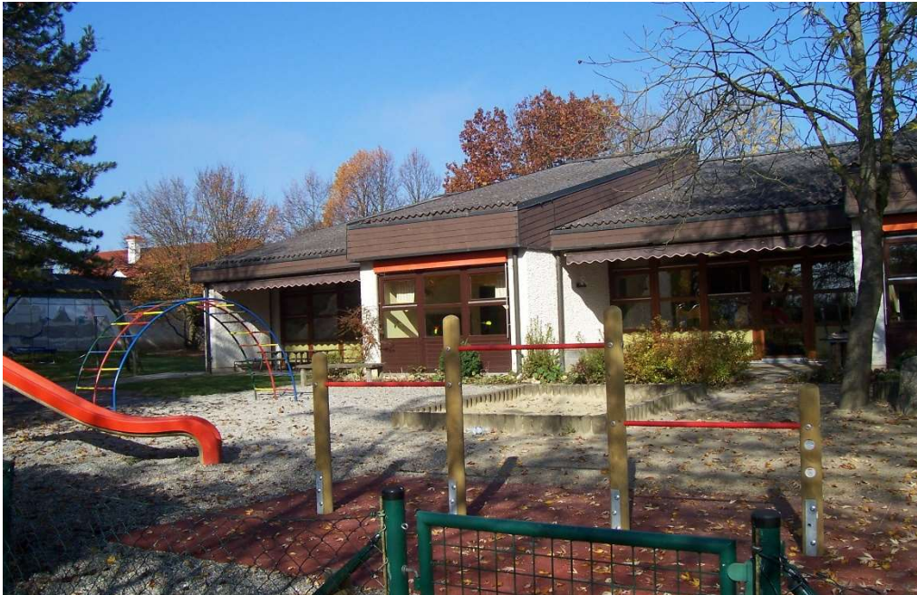
So sah unser Kindergarten vor der Sanierung aus
